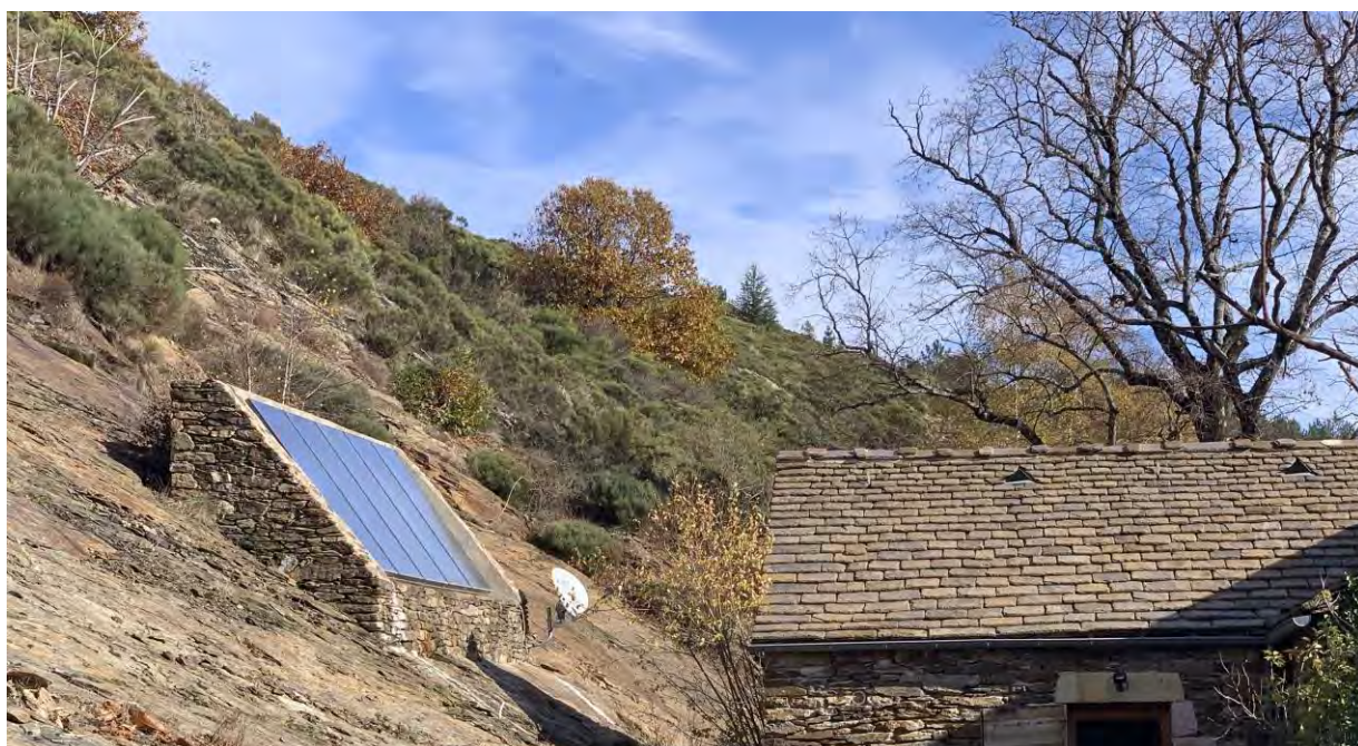
Figure 1. Panneaux solaires intégrés aux bâtiments patrimoniaux de l'Association des bâtisseurs en pierre sèche dans le Parc national des Cévennes. © C. Cibien
